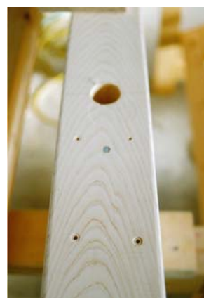
施工検証下穴施工（ヒノキ）
