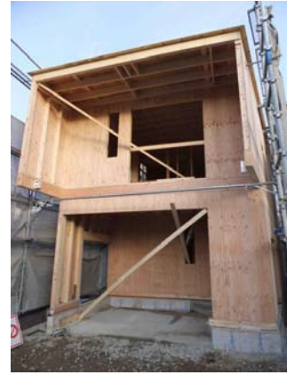
木造枠組壁工法の住宅 パネル組立施工検証（ヒノキ）
