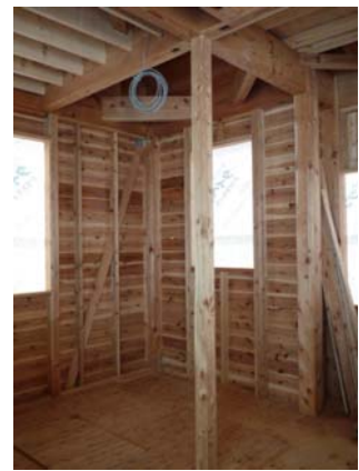
木造軸組み工法の住宅 施工検証（スギ）
