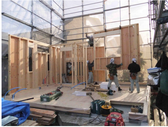
木造枠組壁工法の住宅 パネル組立施工検証（ヒノキ）
