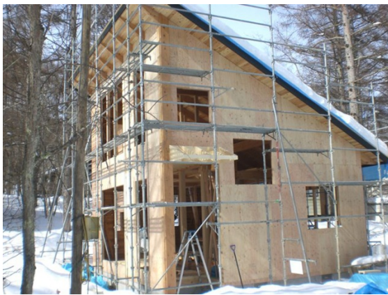
木造軸組み工法の住宅 施工検証（スギ）
